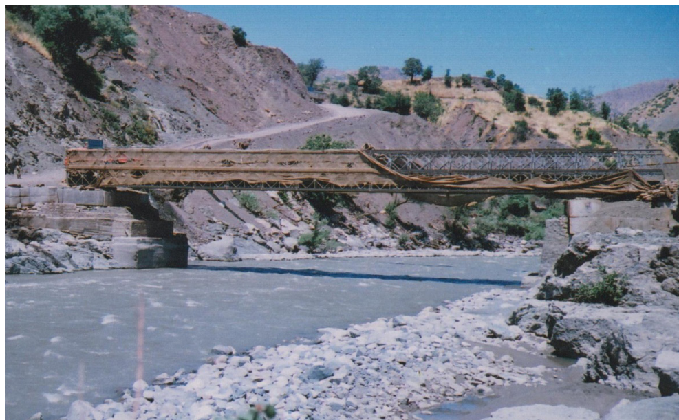
پل پیلی روی رودخانه چومان- منطقه ماووت ۱۳۶۶ برای عبور خودرو- (استتار شده با گونی برای محدود کردن دید هواپیماهای دشمن!)
