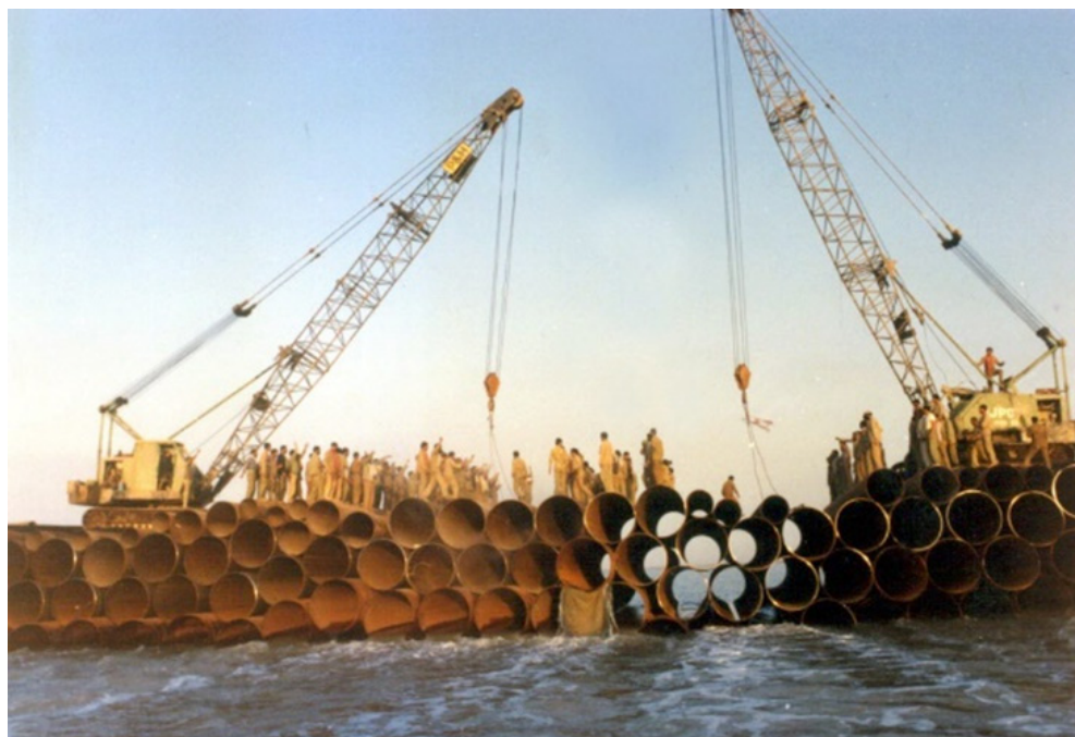
پل ثابت لوله‌ای بعثت بر روی رودخانه‌ی عریض (۱۰۰۰ متر) و خروشان اروند- از شاهکارهای مهندسی رزمی
