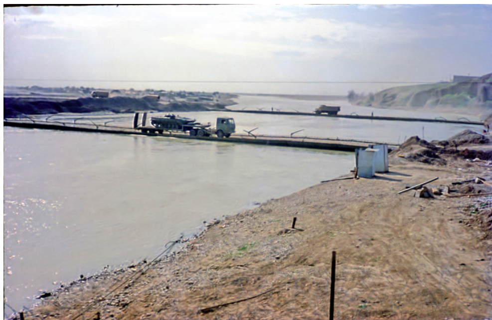
پل روی رودخانه کرخه
