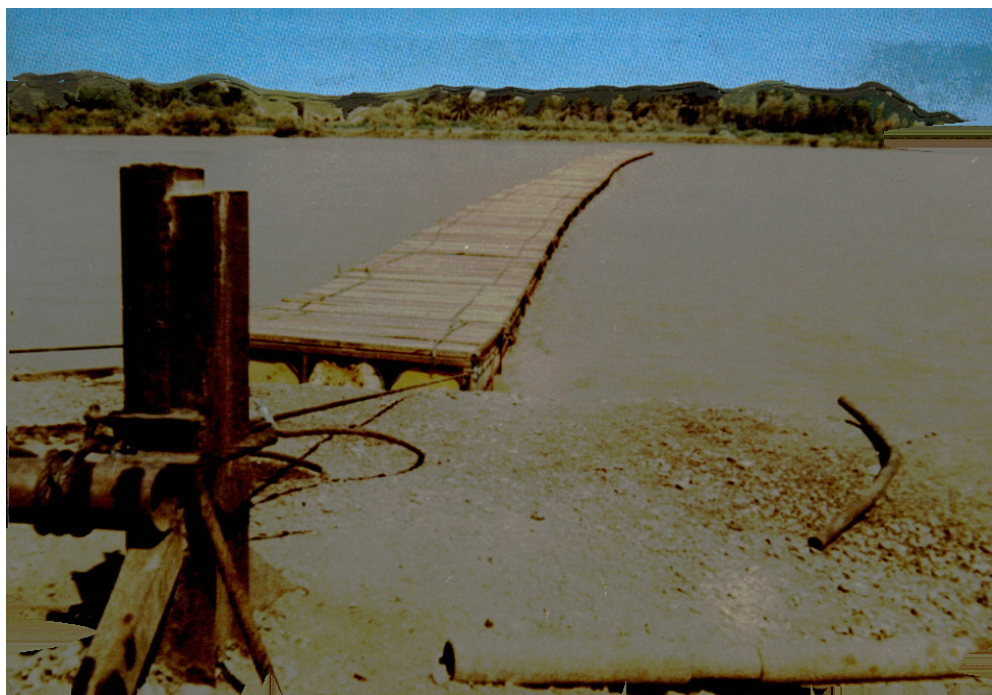
ساخت پل بشکه‌ای و نصب آن بر روی کارون - در سال اول جنگ
