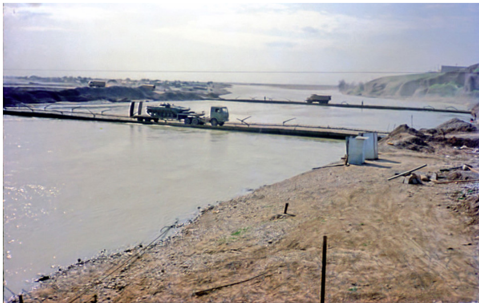
پل روی رودخانه کرخه
