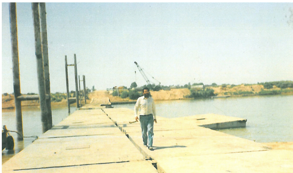
پل شناور بتنی، رودخانه کارون
