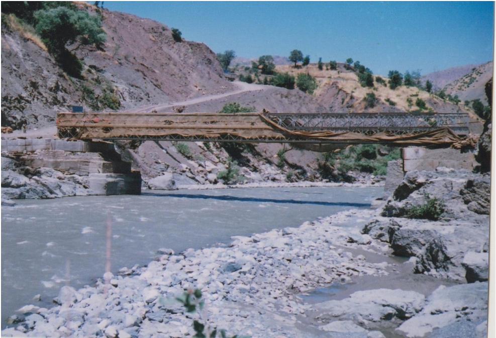
پل پیلی روی رودخانه چومان- منطقه ماؤوت ۱۳۶۶ برای عبور خودرو- (استتار شده با گونی برای محدود کردن دید هواپیماهای دشمن!)
