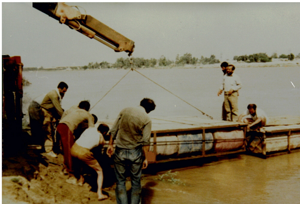
ساخت پل بشکه‌ای و نصب آن بر روی کارون - در سال اول جنگ
