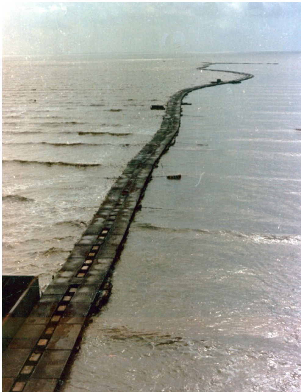
پل شناور خیبر ۲ در حال نصب در هورالعظیم (عملیات بدر، اسفند ۱۳۶۳)
