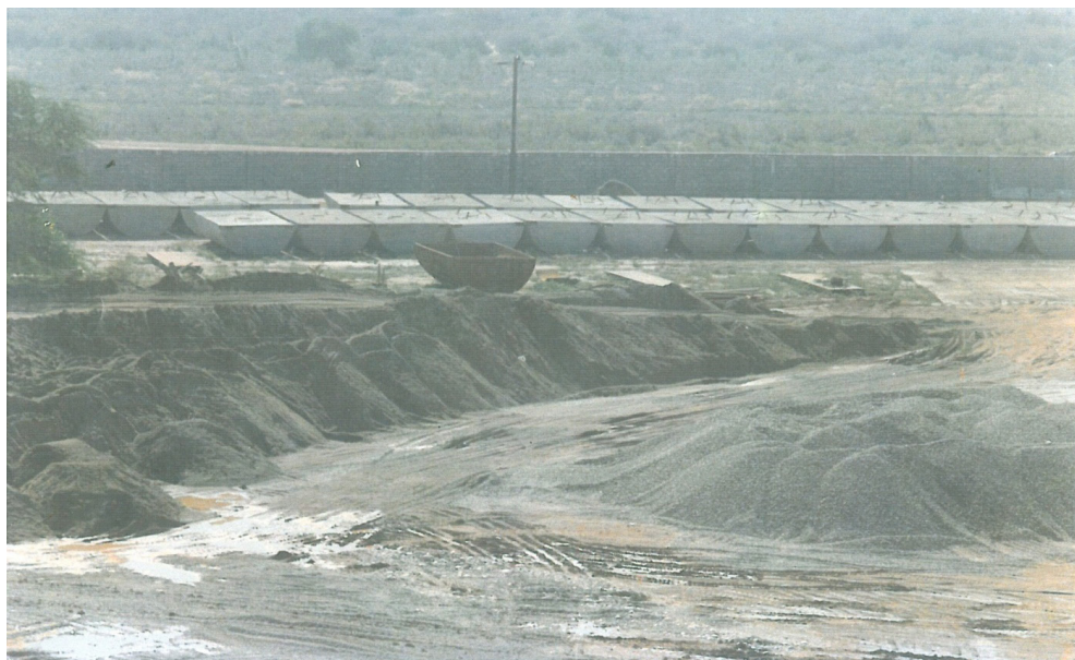
قطعات پل شناور بتنی
