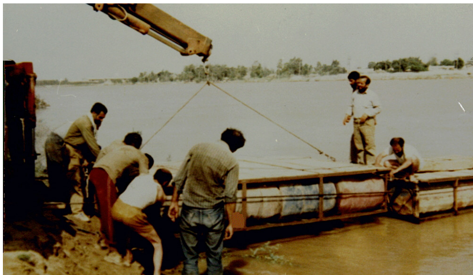
ساخت پل بشکه‌ای و نصب آن بر روی کارون - در سال اول جنگ
