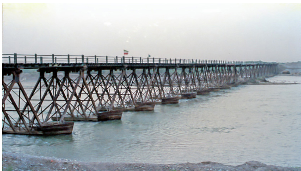
پل شناور دوبه‌ای - اهواز، رودخانه کارون
