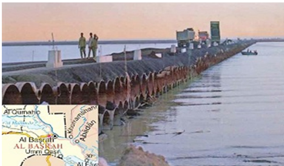
پل ثابت لوله‌ای بعثت بر روی رودخانه‌ی عریض (۱۰۰۰ متر) و خروشان اروند- از شاهکارهای مهندسی رزمی
