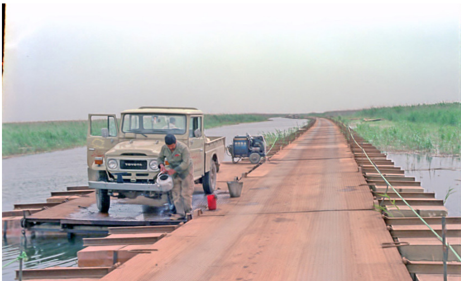
پل شناور ۱۴ کیلومتری خیبر (ادارای پارکینگ) روی هورالعظیم (عملیات خیبر، اسفند ۱۳۶۲) - از شاهکارهای مهندسی رزمی
