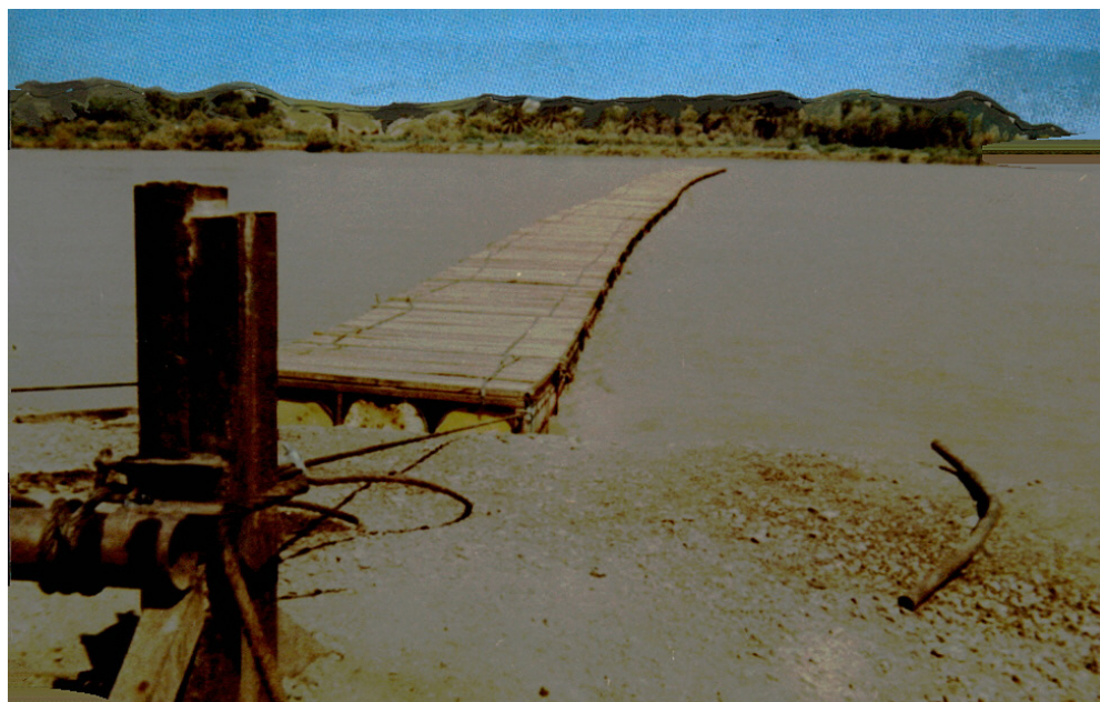
ساخت پل بشکه‌ای و نصب آن بر روی کارون - در سال اول جنگ
