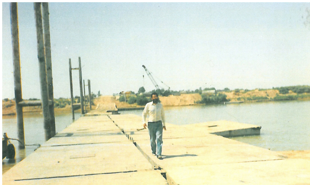
پل شناور بتنی، رودخانه کارون
