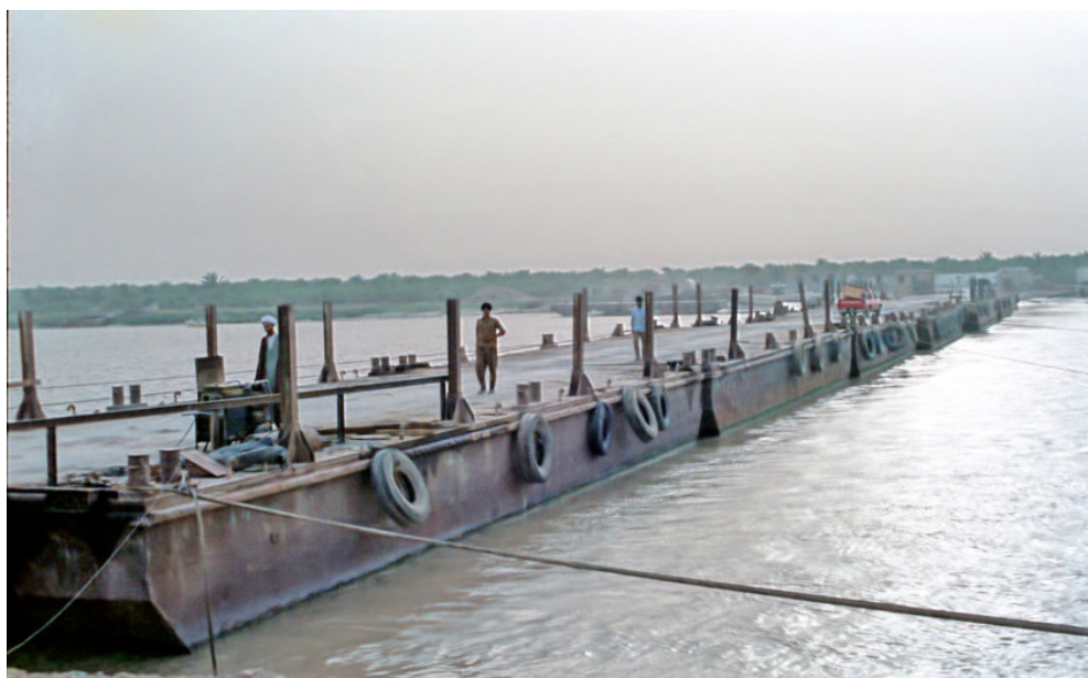
پل شناور دویه‌ای - اهواز، رودخانه کارون
