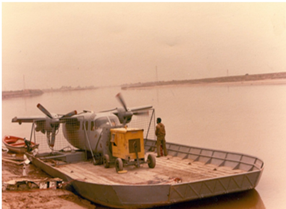
طراذه خودکشی، با استفاده از نیم تنه هواپیمای اسقاطی و موتورهای توربو فن آن، برای عبور از اروند
