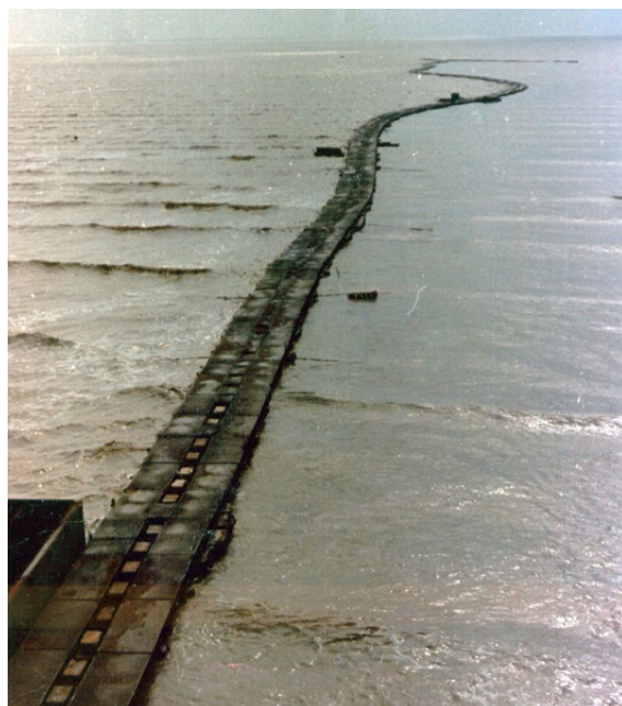
پل شناور خیبر ۲ در حال نصب در هورالعظیم (عملیات بدر، اسفند ۱۳۶۳)
