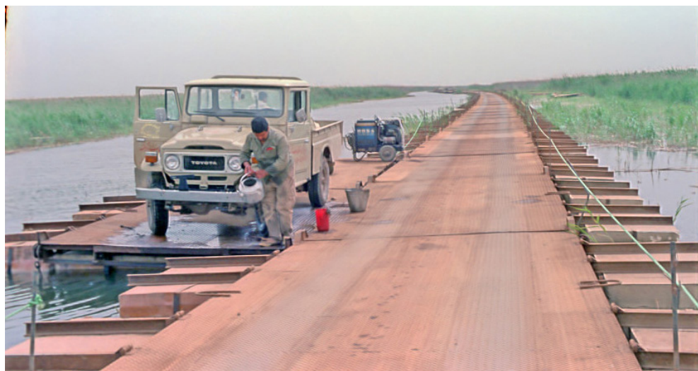
پل شناور ۱۴ کیلومتری خیبر (دارای پارکینگ) روی هورالعظیم (عملیات خیبر، اسفند ۱۳۶۲) - از شاهکارهای مهندسی رزمی
