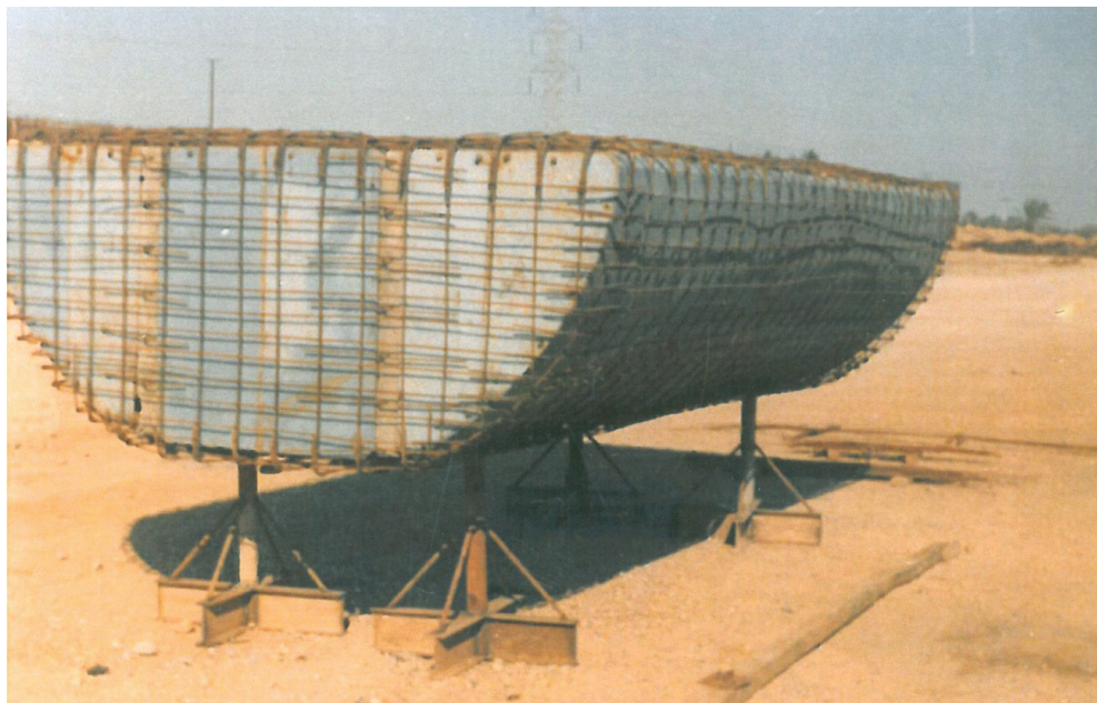
قالب پل شناور بتنی
