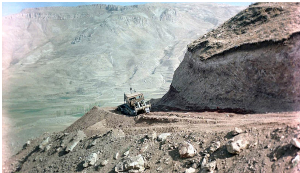
ترانشه‌زنی واحداث جاده کوهستانی
