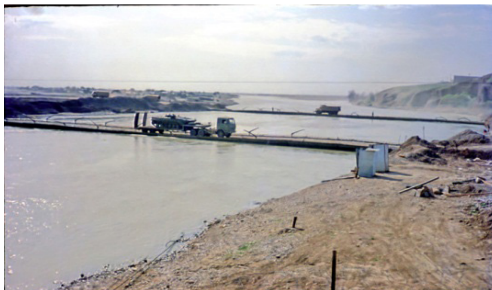
پل پی.ام.پی بر روی رودخانه کرخه در منطقه عمیات فتح المبین، بهار ۱۳۶۱
